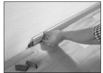
Randfugen mit passenden Sockelleisten aus dem umfangreichen Parador Sortiment abdecken.
