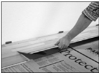
Die nächste Reihe wieder von links beginnen. Klicken Sie die Dielen einfach längsseitig zusammen. Eine Verleimung der Dielen ist nicht erforderlich.
