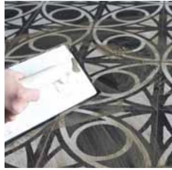
Mit einem Fugbrett wird der Fugmörtel in die Fugen eingepresst. Fugmörtel so lange einarbeiten, bis die Fuge nicht mehr fällt, d.h. dass der Mörtel die Fuge komplett füllt.
