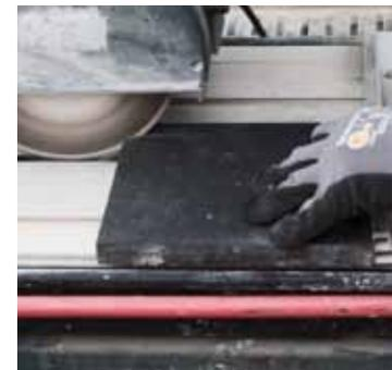
Wichtig ist das **trockene Schneiden** der Platten, um das Aufnehmen von Feuchtigkeit zu vermeiden.
