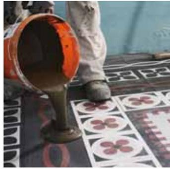
Der Fugmörtel wird aus zwei Teilen Trasszement und einem Teil Quarzsand unter Zugabe von Wasser in einer joghurtartigen Konsistenz hergestellt und auf den besenreinen Plattenboden aufgebracht.
