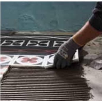
Zementmosaik- und Terrazzoplatten werden traditionell mit so **geringer Fugenbreite** wie möglich verlegt. So erreicht man, dass ein flächiger Belag entsteht und Muster ohne störendes Fugenraster zur Geltung kommen und die Kanten sich gegenseitig schützen.
