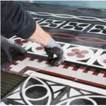
Verlegung mit **sehr geringer** Fugenbreite, ohne Fugenkreuze. Die Verfugung erfolgt nach dem Austrocknen der Platten.
