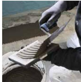
Kleber mit einer 10er Zahnkelle auf Boden/Wand **und** Platte auftragen. So hat man eine ausreichende Kleberdicke, um beim Andrücken eine ebene Oberfläche ohne Überzahn zu erzielen. Zur nahezu hohlraumfreien Verlegung ist **unbedingt** das **Buttering-Floating Verfahren** anzuwenden.
