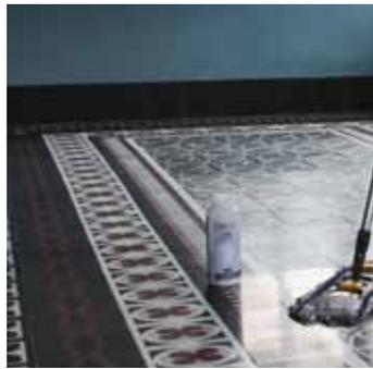
im Kreuzgang dünn auf die trockene Oberfläche aufgetragen. Nach ca. 1 Stunde Trockenzeit wird eine zweite Schicht vollflächig im Kreuzgang aufgebracht. **Überschüsse und Streifenbildung sind zu vermeiden.** Volle Beständigkeit wird nach 7 Tagen erreicht. Weitere Informationen finden Sie direkt auf dem Flaschenetikett.
