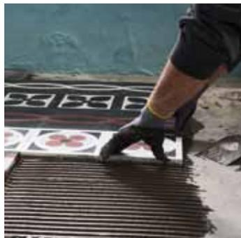
Platten sorgfältig ausrichten, um **Überzähne zu vermeiden**. Schnitte lassen sich am besten mit einem Diamantblatt trocken ausführen. Selbst Gehrungen können so exakt geschnitten werden, dass saubere Stöße an Außenkanten möglich sind.
