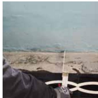
Zu schneidende Platten im Randbereich erst nach Verlegung des Mittelmusters ausmessen und trocken schneiden.
